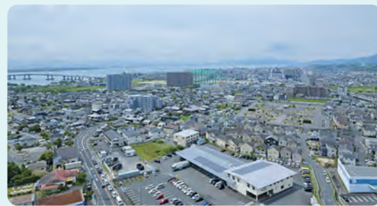
上空から見た北大津センター
