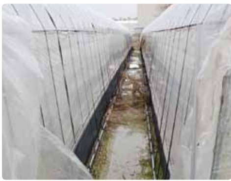
野洲エリアでは、ハウス内に土を盛り、圃場を地面よりも高くすることで、水はけがよくなるように工夫している
