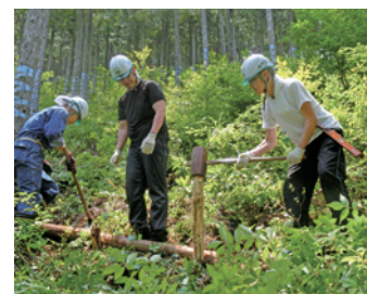
作業道の崩落を防ぐため杭を打つ
