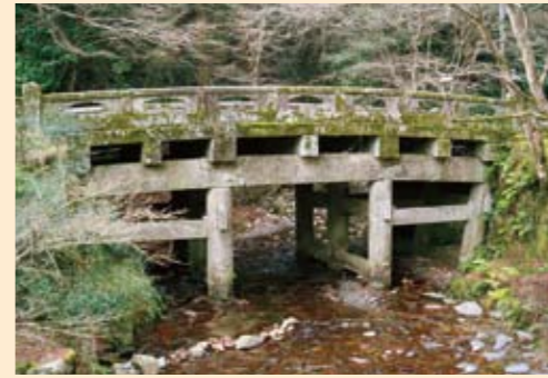
▲ 日吉三橋のひとつ大宮橋
